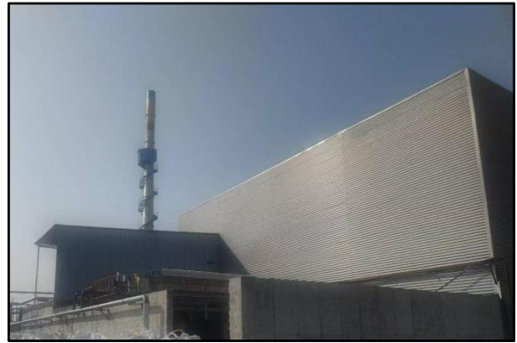
锅炉房、燃料仓（已建）
