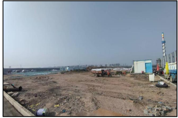
厂区南侧现状
