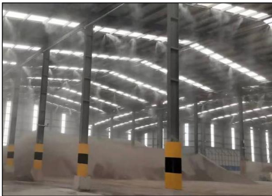
料库内部现状
