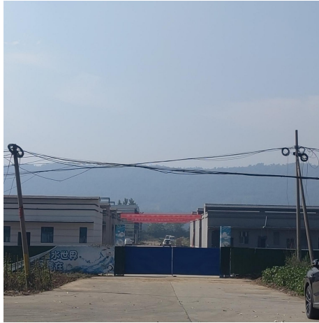
本项目现场（含厂区现有建筑）
