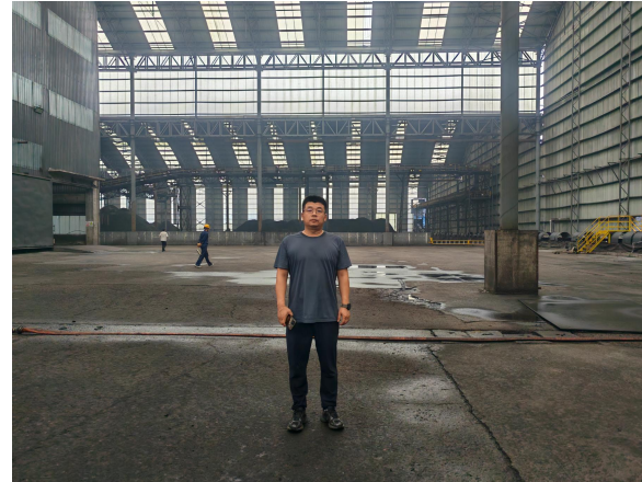
工程师看现场照片
