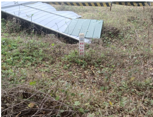
项目东侧开源路天然气管道
