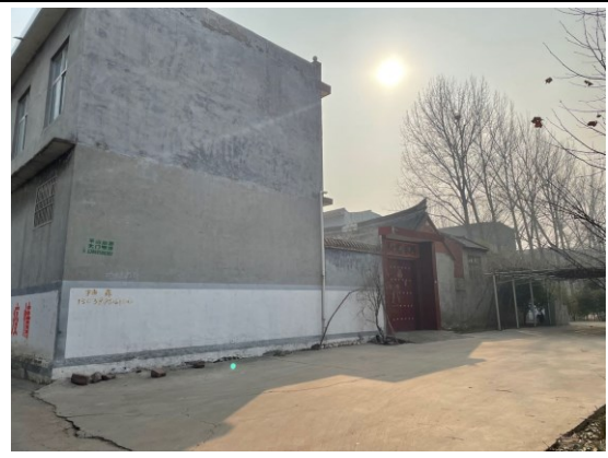
项目东侧坡刘村
