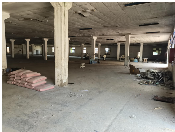
项目车间内部现状
