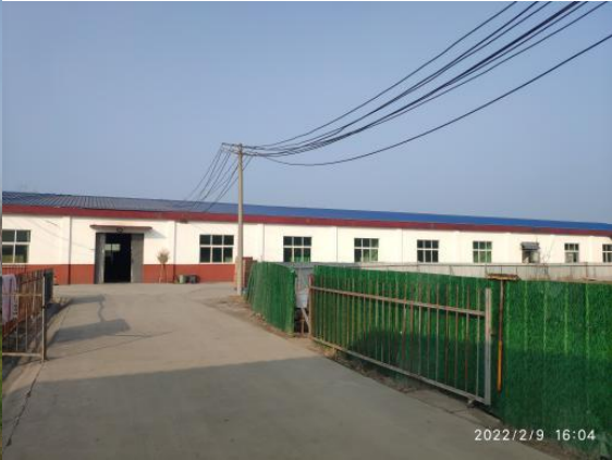
厂房外部现状
