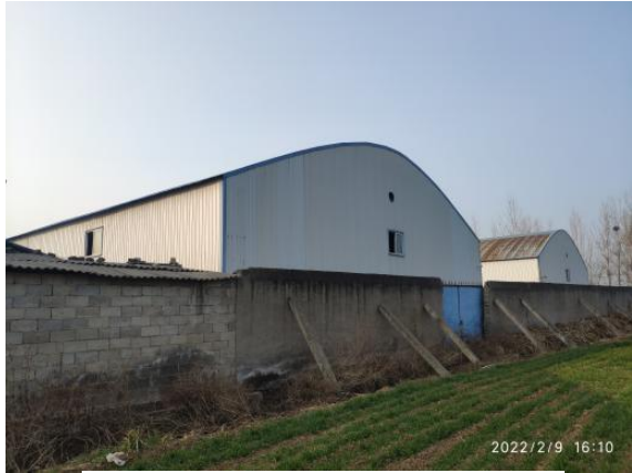
厂区北侧现状
