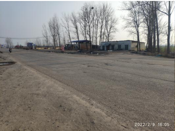
厂区进口道路现状
