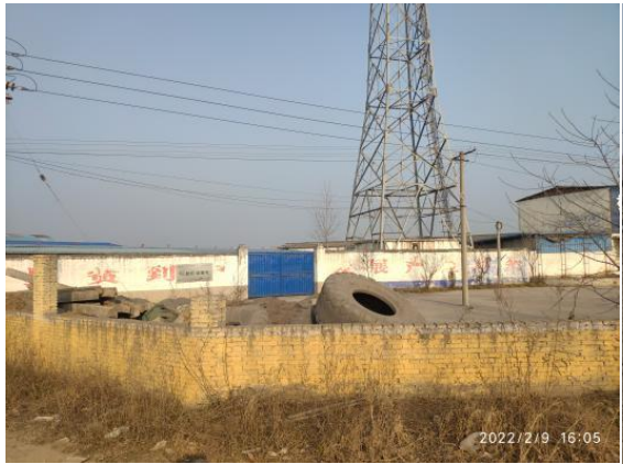
厂区东南侧现状
