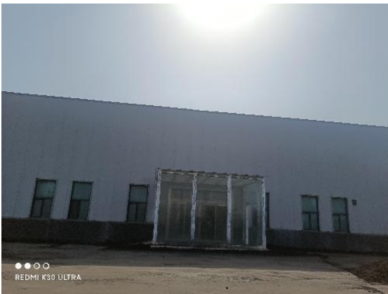
项目南侧河科科技厂房
