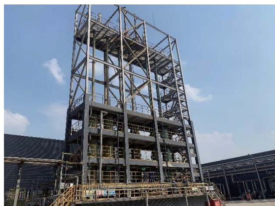
现有工程尾气吸收塔
