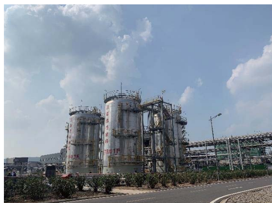
现有工程储罐
