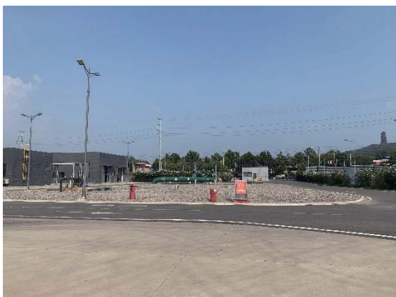
现有工程事故水池（地下）
