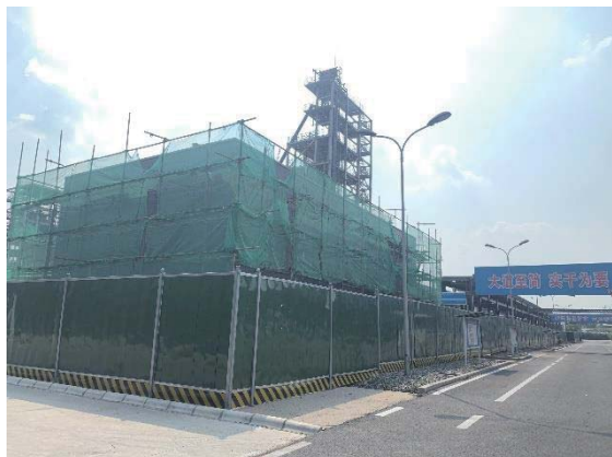
一期工程（冷氢化技改）现状
