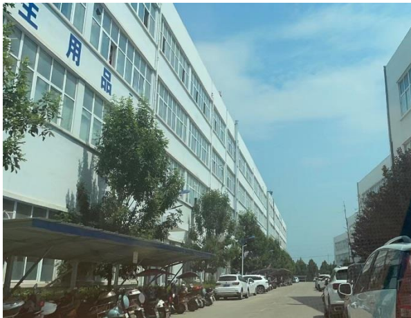
项目北侧 19号厂房
