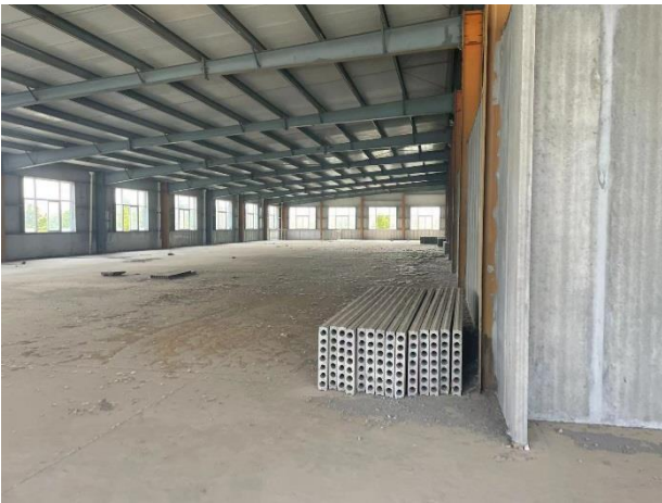
项目厂房内部
