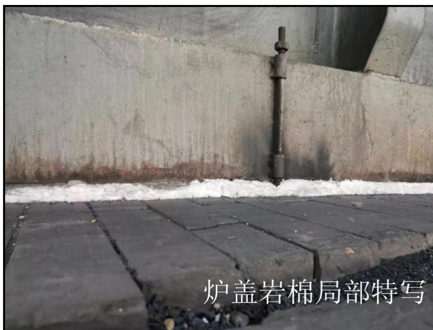
图 4-4 环式焙烧炉炉盖加岩棉局部特写
