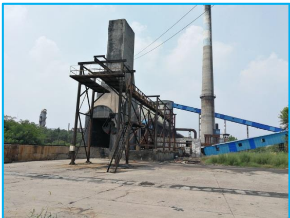
项目拟建厂址现状 1
