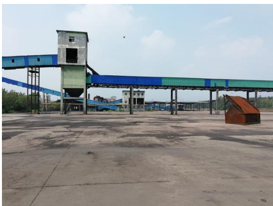
项目拟建厂址现状 4
